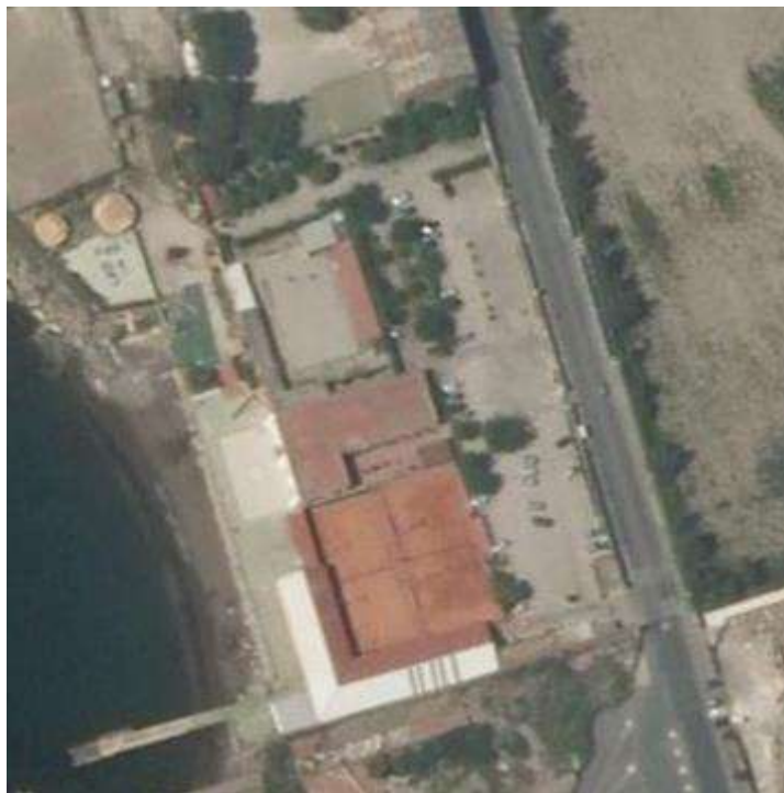
Foto aerea del Circolo ILVA allo stato attuale
